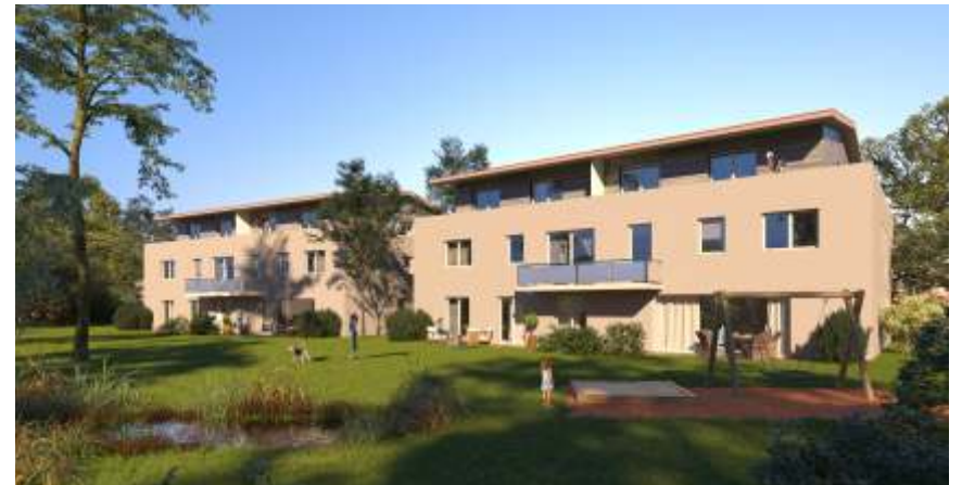
Bermatingen-Ahausen – Meersburger Str. 36 + 38 | Fertigstellung 2023
